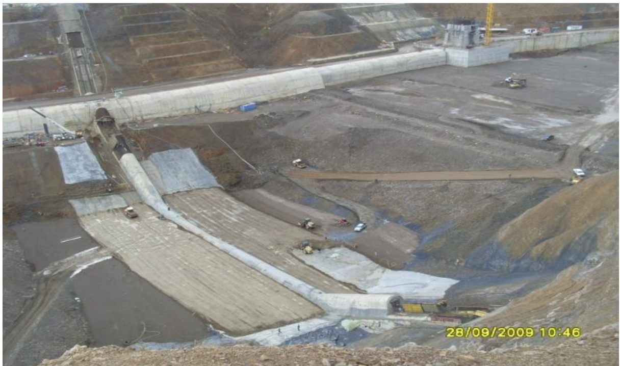
Fig. 1.6 — Stabilisation par compactage de surface (Cas d'une digue de barrage en terre de Kef-Eddir construit à Tipaza, Algérie).
