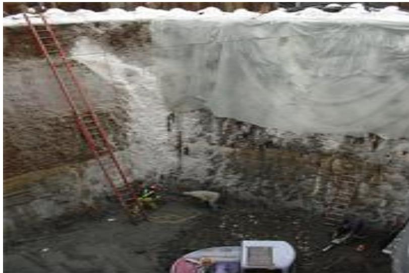
Fig. 1.12 — Stabilisation provisoire des parois d'un fond par la technique de congélation.
