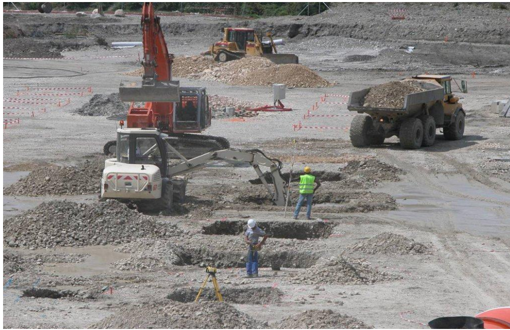
Fig. 1.9 — Amélioration d'un terrain par induction hydraulique (Substitution du sol par du gravier dans un chantier à Saint Martin d'Hères en 2006, France).
